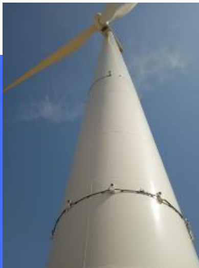
Uno o dos anillos de cámaras fijadas alrededor de la torre
